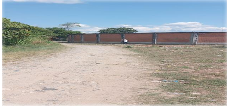
ANTES DE EJECUCIÒN
