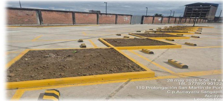
DESPUES DE EJECUCIÒN
