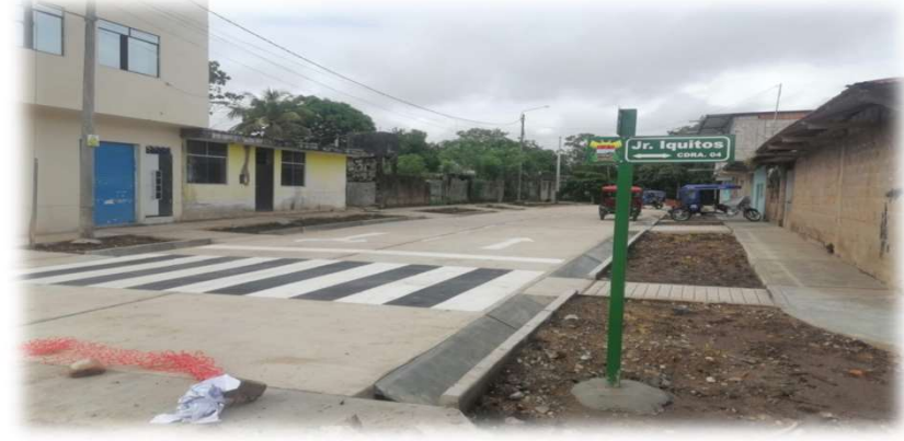
DESPUES DE EJECUCIÒN
