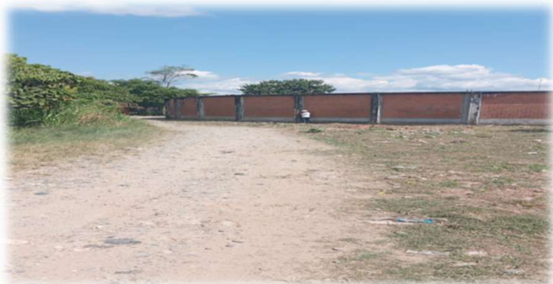
ANTES DE EJECUCIÒN
