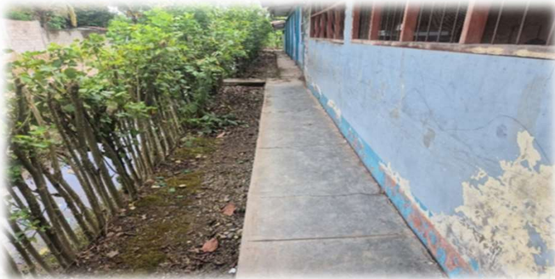
ANTES DE EJECUCIÓN
