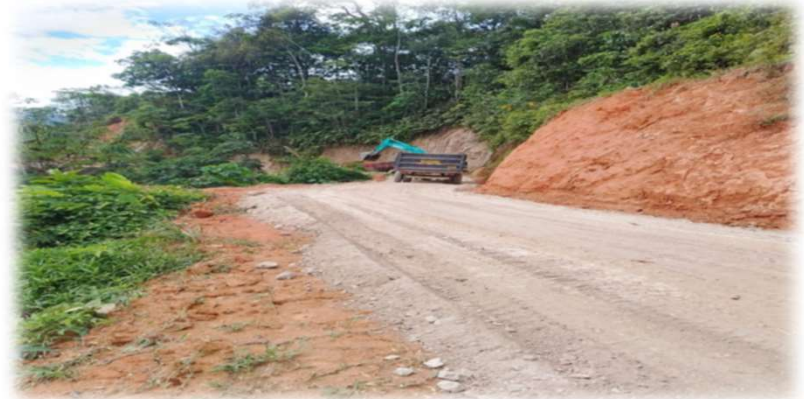
DESPUES DE EJECUCIÓN
