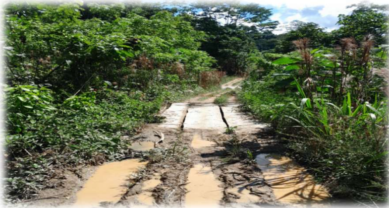
ANTES DE EJECUCIÓN
