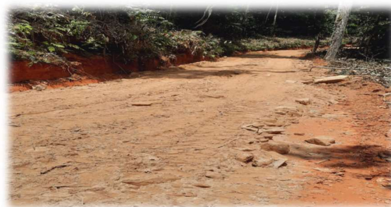
DESPUES DE EJECUCIÒN
