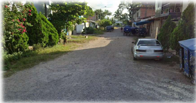
ANTES DE EJECUCIÒN
