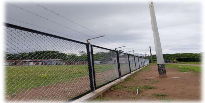
DESPUES DE EJECUCIÓN
