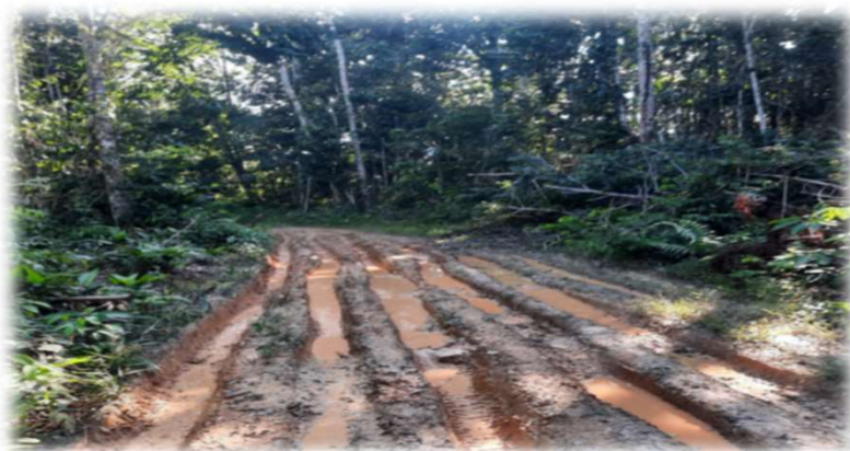
ANTES DE EJECUCIÒN
