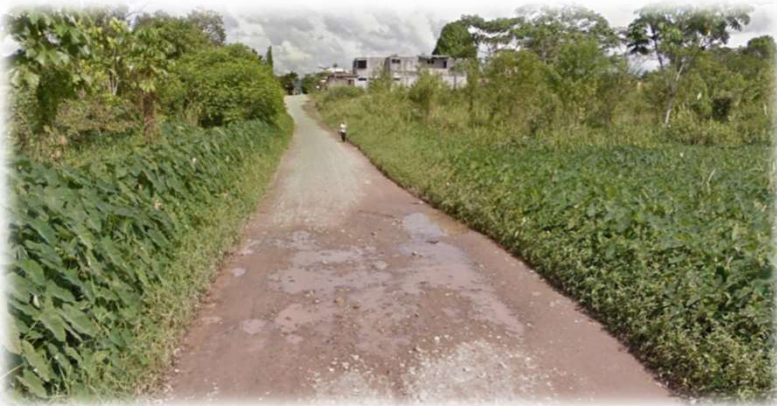
ANTES DE EJECUCIÒN
