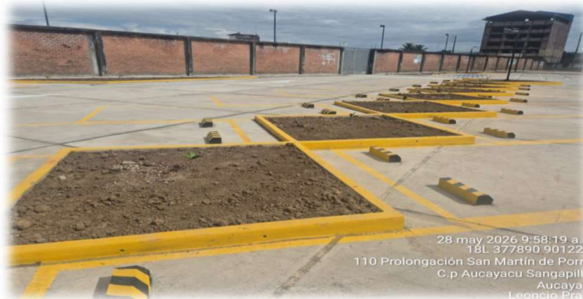
DESPUES DE EJECUCIÒN
