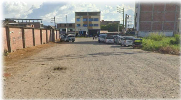
ANTES DE EJECUCIÓN
