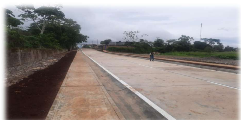
DESPUES DE EJECUCIÒN
