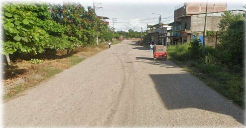
ANTES DE EJECUCIÒN
