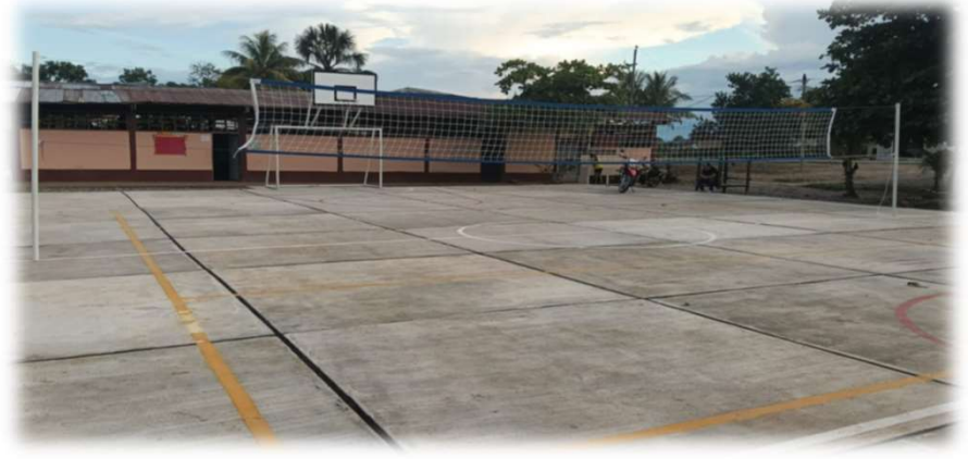
DESPUES DE EJECUCIÓN
